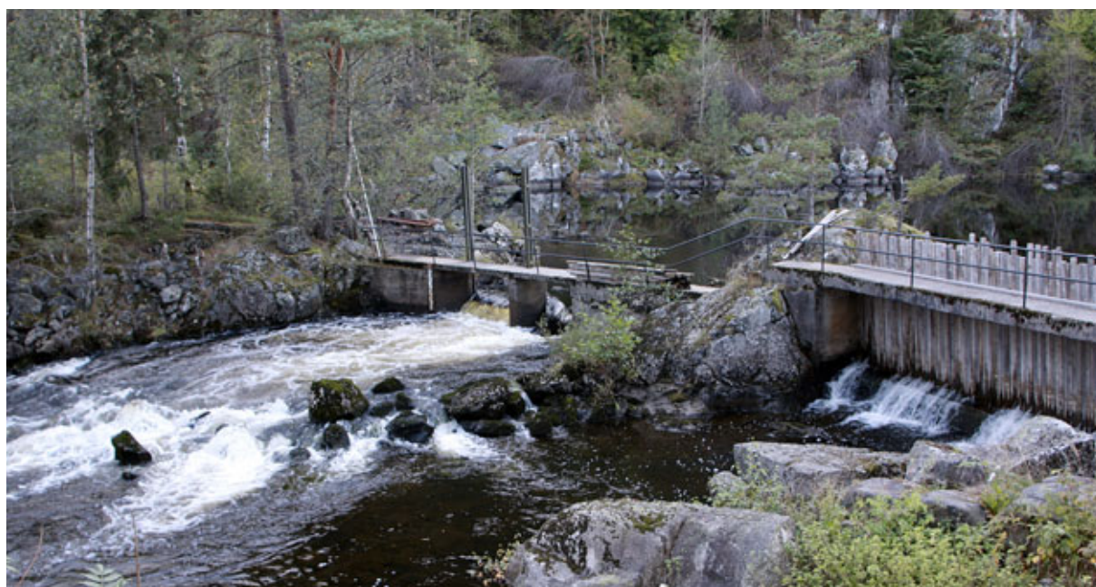
Storelva, dam utløp Ubergsvatnet.
